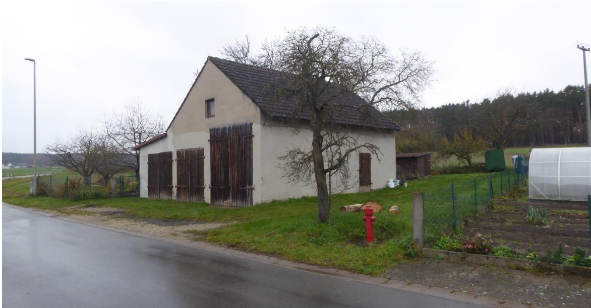
Abbildung 1: Blick von Osten auf die Einbeziehungsfläche (Eigene Aufnahme, 22.12.2022)
